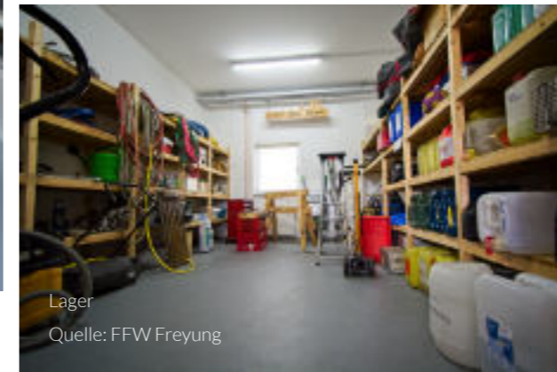
Schlauchpflegeanlage Quelle: FFW Freyung
